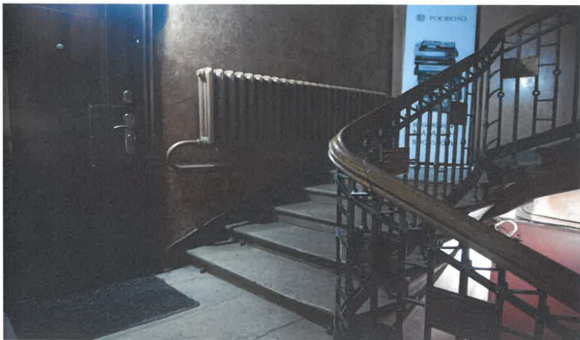
Лестничная площадка между первым и вторым этажами по парадной лестнице.
