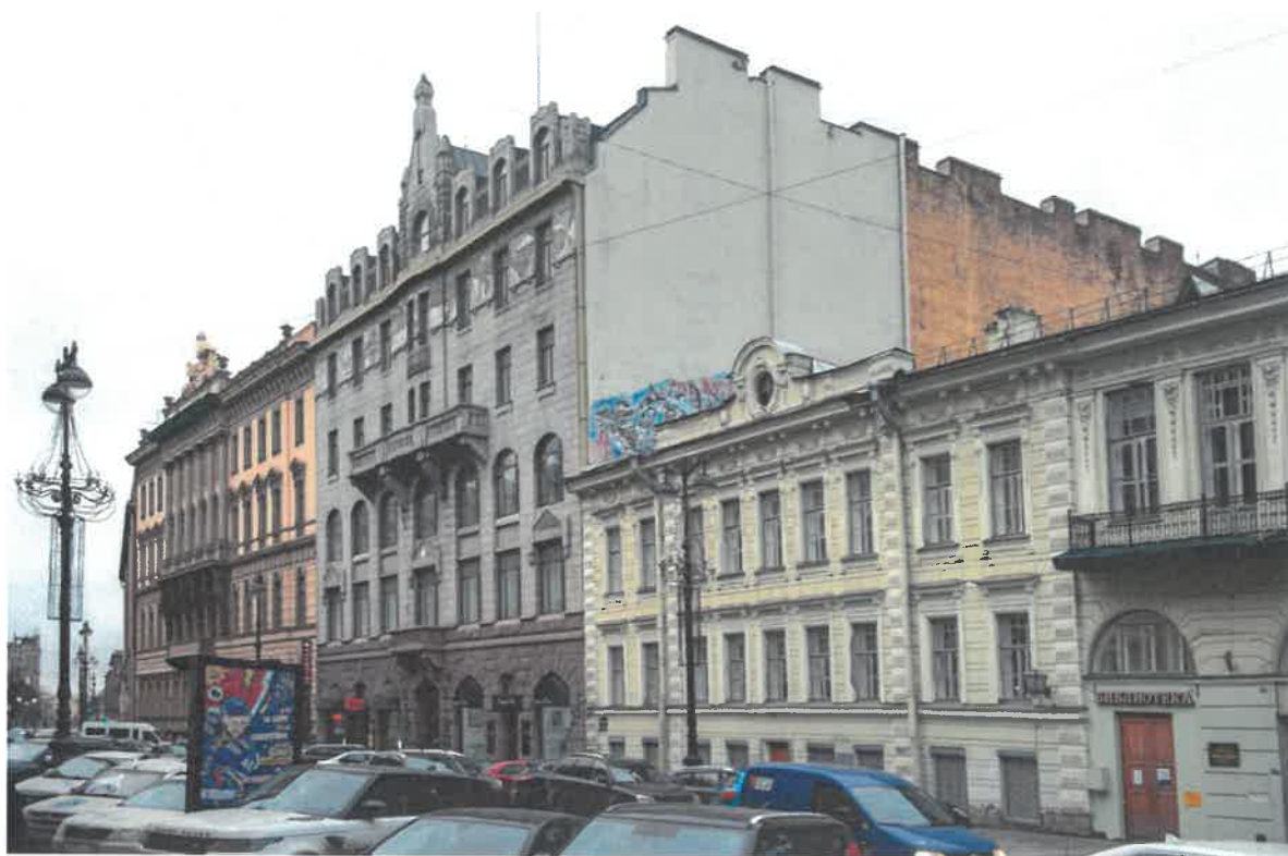
Территория, прилегающая к зданию.
